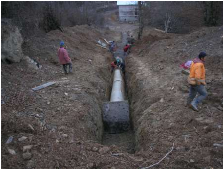
TLAČNI CJEVOVOD U IZGRADNJI
