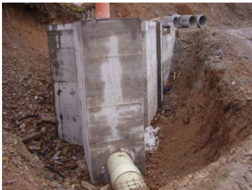
BETONSKI VODOSTAN U IZGRADNJI
